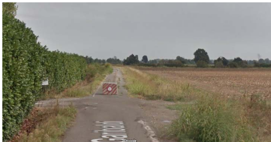
Attestamento nord del percorso ciclopedonale di via Garibaldi
