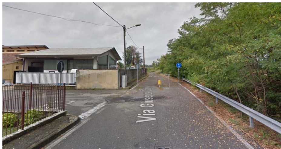
Attestamento sud (su via dei Mille) del percorso ciclopedonale di via Garibaldi
