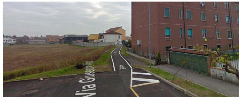
Tratto terminale del percorso ciclopedonale lungo via Verdi tra Triginto e Mediglia
